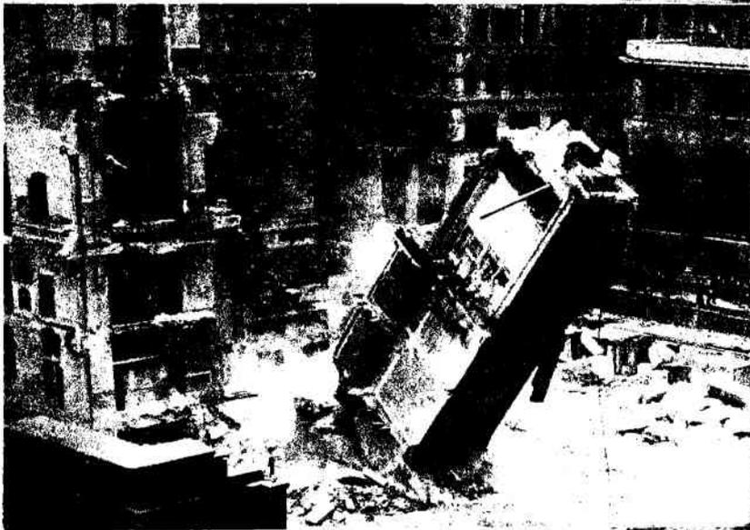
**COMO CASA DE NAIPES.**—Este edificio valorado en un millón 150 mil pesos, que existía en Boston, fué destruido para edificar otro, cuya moderna estructura se estima en 3 millones de pesos. Con tractores y cables de acero se efectuó la demolición en menos de dos horas. Esta foto apresa una interesante fase del hecho.
